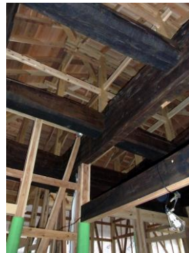
大梁を活用するよう設計 今も生き続けている古材
